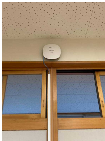
各教室のルーター 工事も完了
