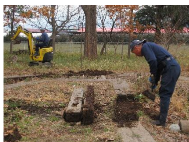
老朽化して破損・空洞化した枕木の撤去
