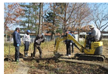
新しい橋の設置
