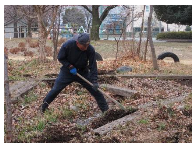
老朽化して破損・空洞化した枕木の撤去
