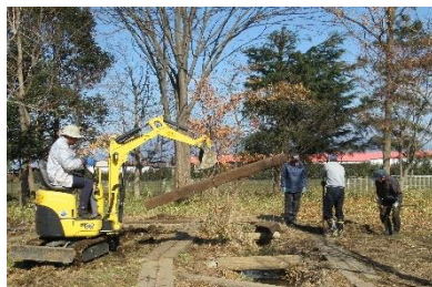
新しい枕木のはめ込み
