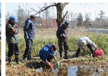
排水ポンプでの水抜き
