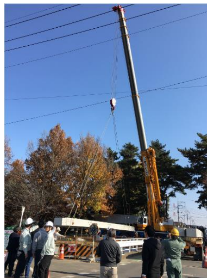
学校の東側 鹿島橋への橋桁架け
