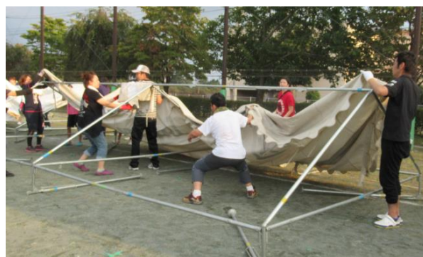
屋根に幌をかぶせます。
